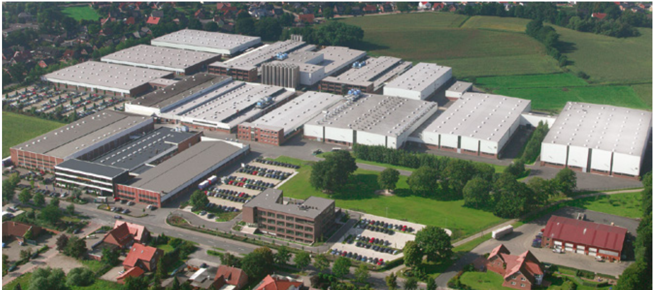
Plant 1, Germany: Pöppelmann GmbH & Co. KG, Kunststoffwerk-Werkzeugbau, Lohne.
