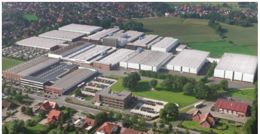
Deutschland, Werk 1: Pöppelmann GmbH & Co. KG, Kunststoffwerk-Werkzeugbau, Lohne.
